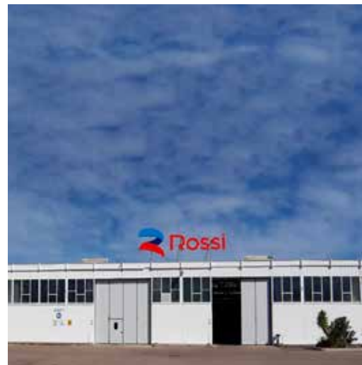
Strutture della Divisione Planetaria Lecce - Italia
