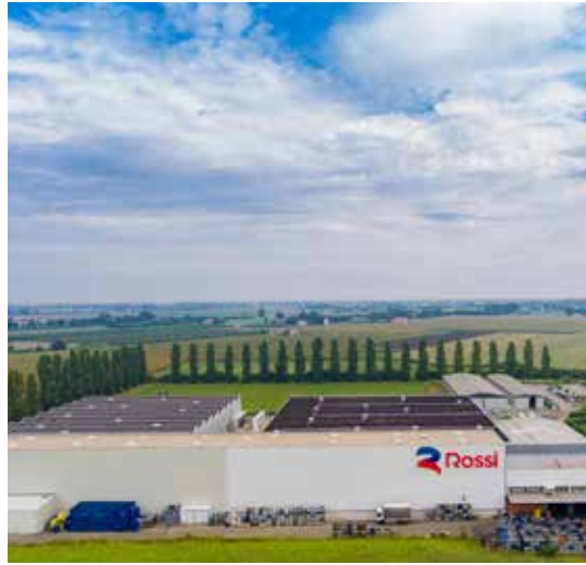
Hochpräzise Fertigungsanlage Ganaceto (Modena) - Italien
